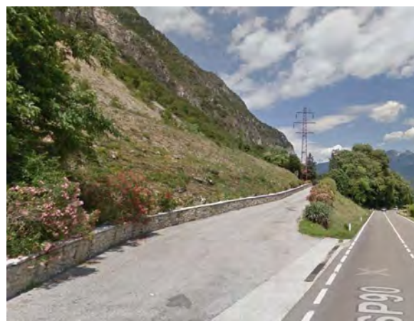
1 | Ingresso alla strada privata d'accesso alla cava dalla SP90 (GoogleMaps - Streetview)
