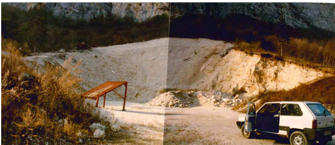
9 febbraio 1990 – prima dell'intervento di ripristino
