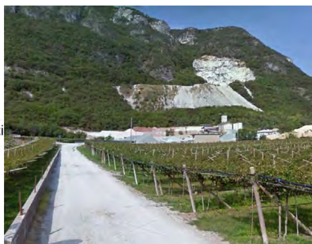
1 | Vista della strada secondaria che porta alla cava (GoogleMaps - Streetview)
