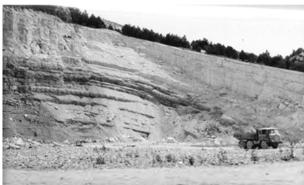
In Progetto di sviluppo della cava (prot. n°303/62) in Polizia Mineraria Cave, 161/4 Rovereto
