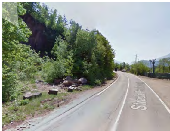
1 | L'ingresso alla cava, in corrispondenza della SP 76 (GoogleMaps - StreetView)
