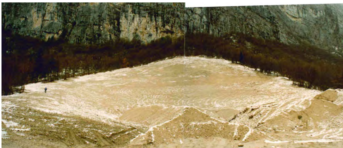
aprile 1992 - dopo l'intervento di ripristino
